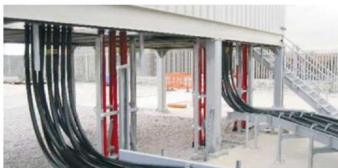
La bandeja metálica porta-cables, se define como una estructura metálica, fabricadas bajo la norma NEMA VE – 1: “las bandejas son fabricadas en un bastidor prefabricado, para que salgan a una sola medida y escuadradas, para que al montaje las bandejas queden perfectamente encajadas y alineadas” Su función principal es la conducción segura de cableados eléctricos aéreos.
